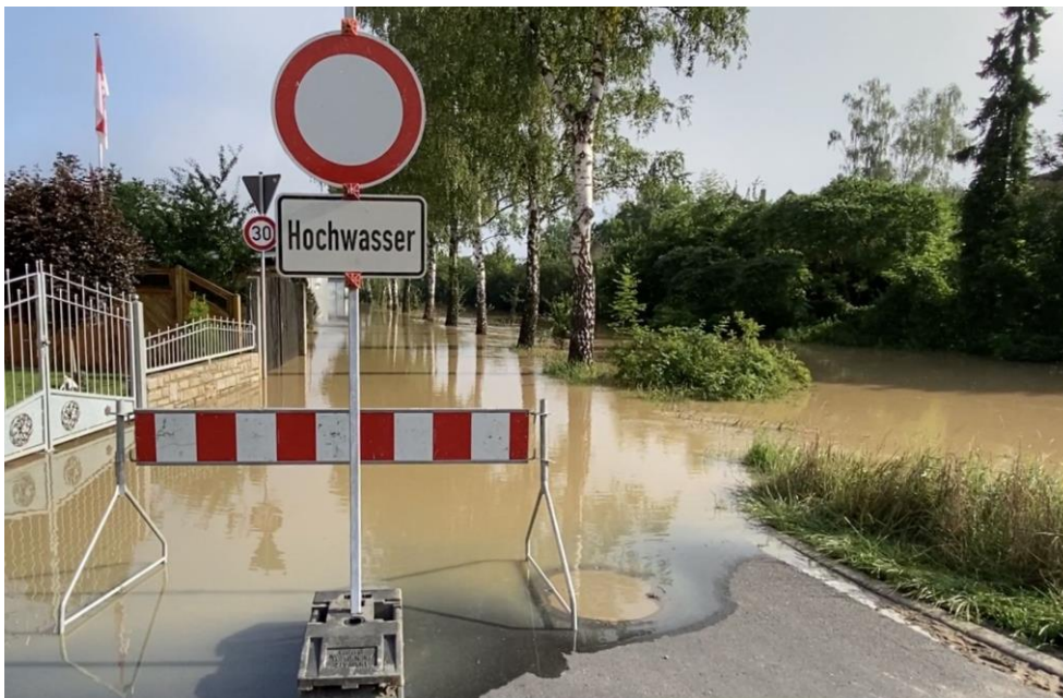
Abbildung 1: Hochwasser in Zeilitzheim (Juli 2021)
